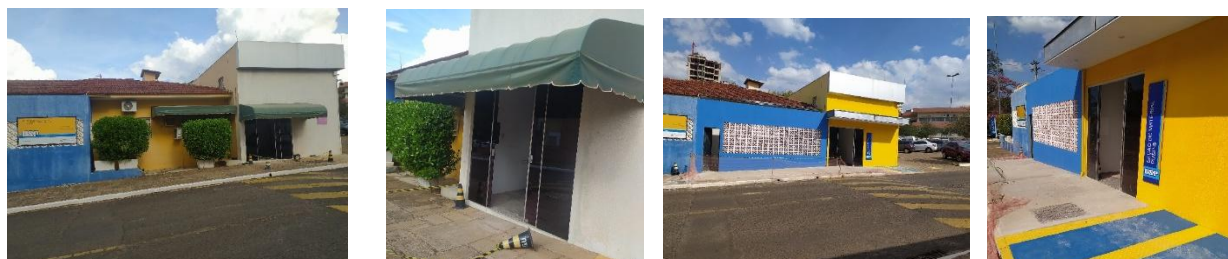
Fotos ilustrativas da situação antes e depois da obra
