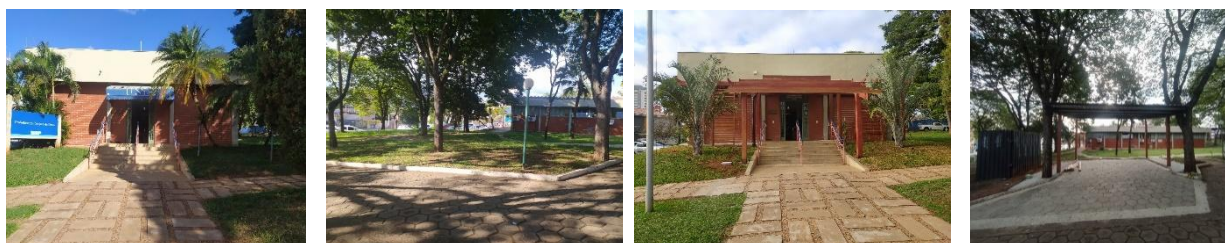
Fotos ilustrativas da situação antes e depois da obra
